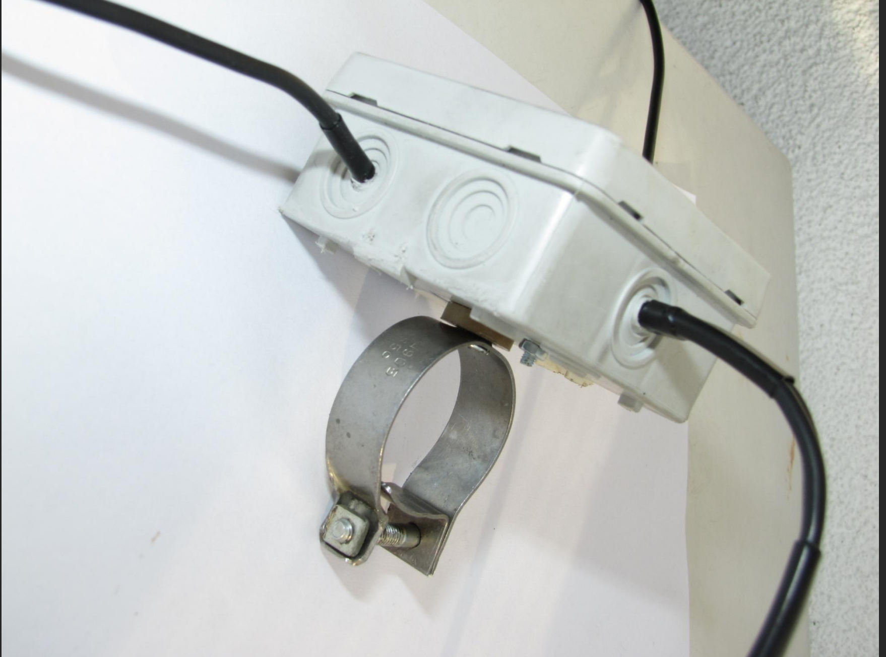
Obudowa podłączenia linii 2-przewodowych do wibratorów
