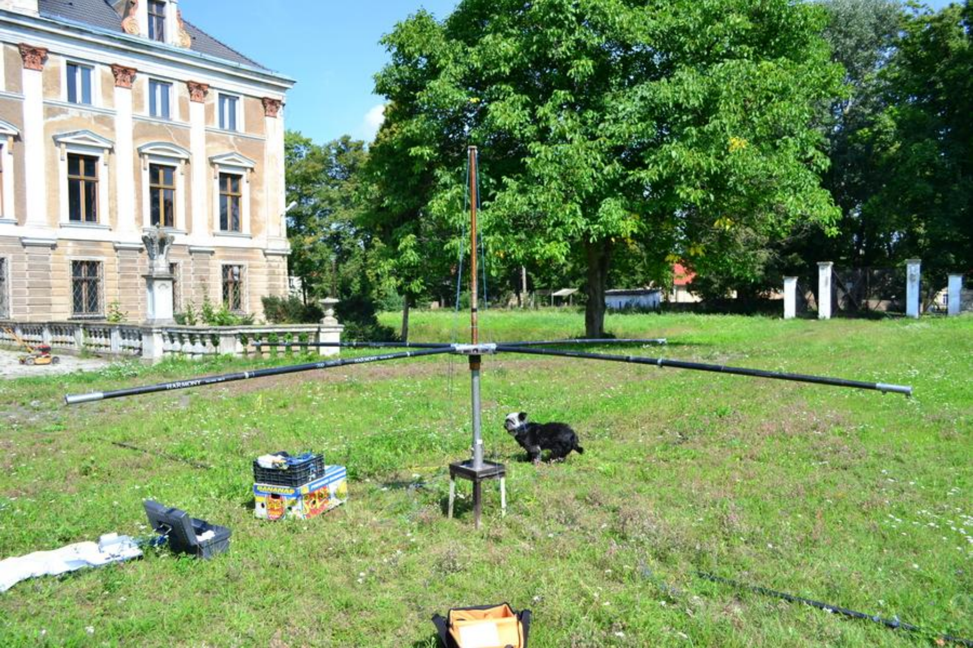
Montaż tyczek rozporowych
